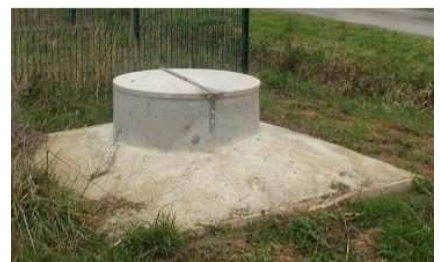
dalle ciment et capot étanche
