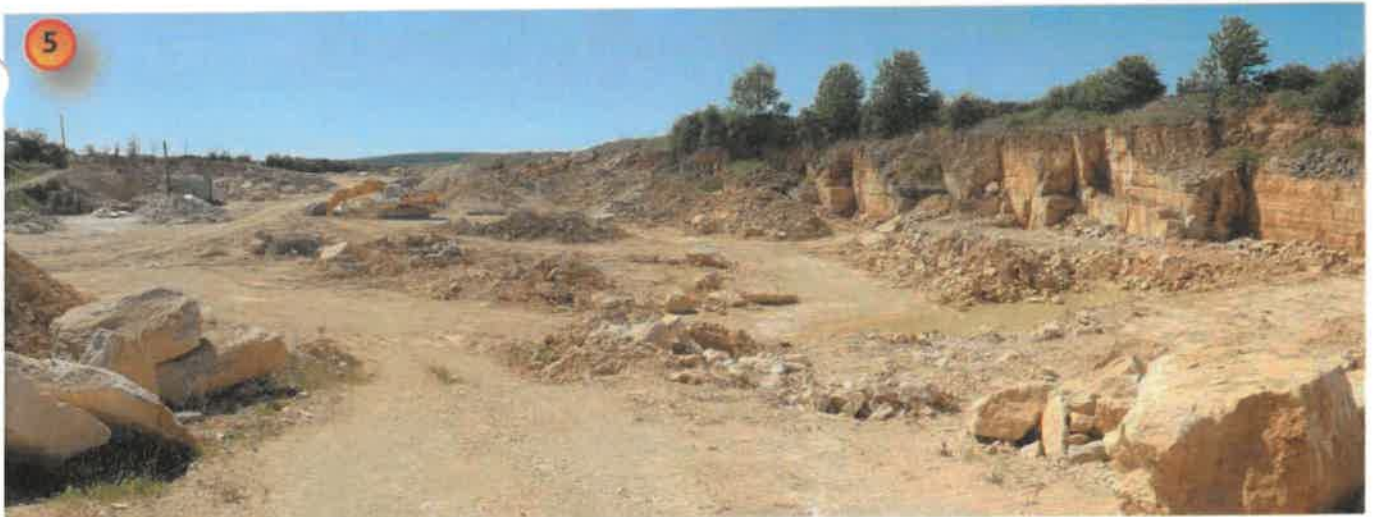
5 - Vue sur le front de taille depuis l'Est
