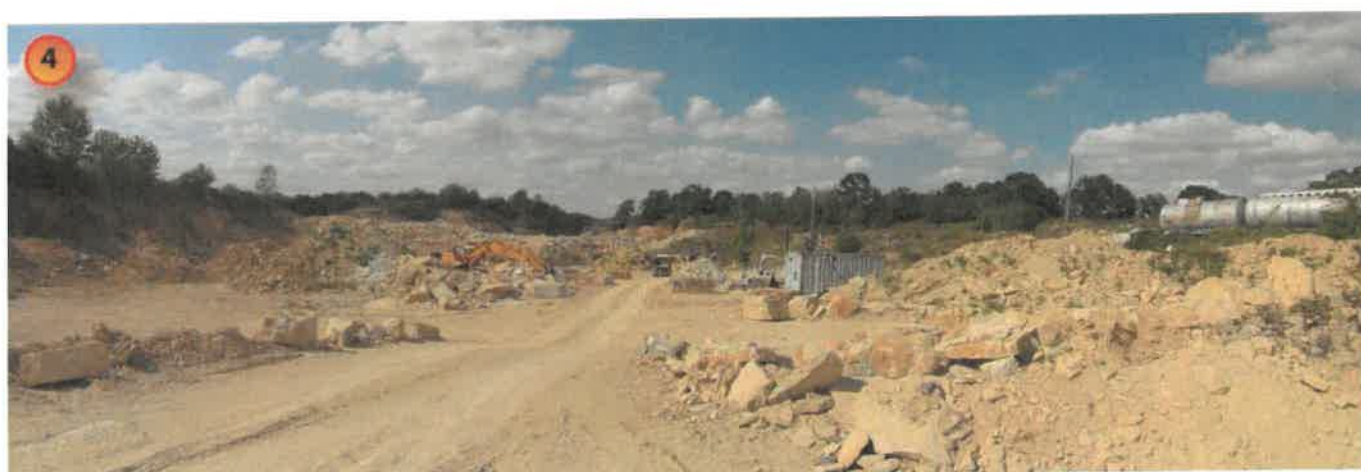
4 - Vue d'ensemble depuis le pieds de la rampe
