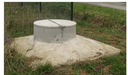
dalle ciment et capot étanche
