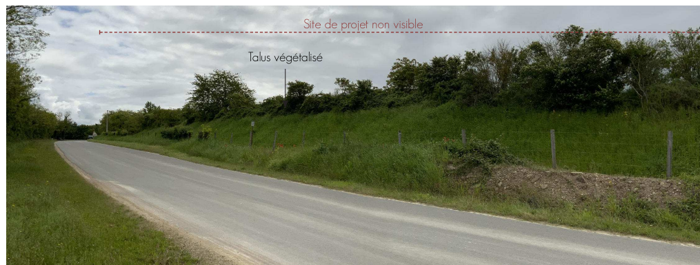
Vue 2b - Vue depuis l'entrée du site de la carrière
