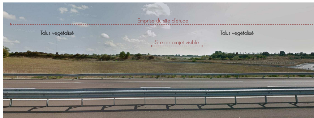
Vue 1a - Vue depuis la route Nationale N7
