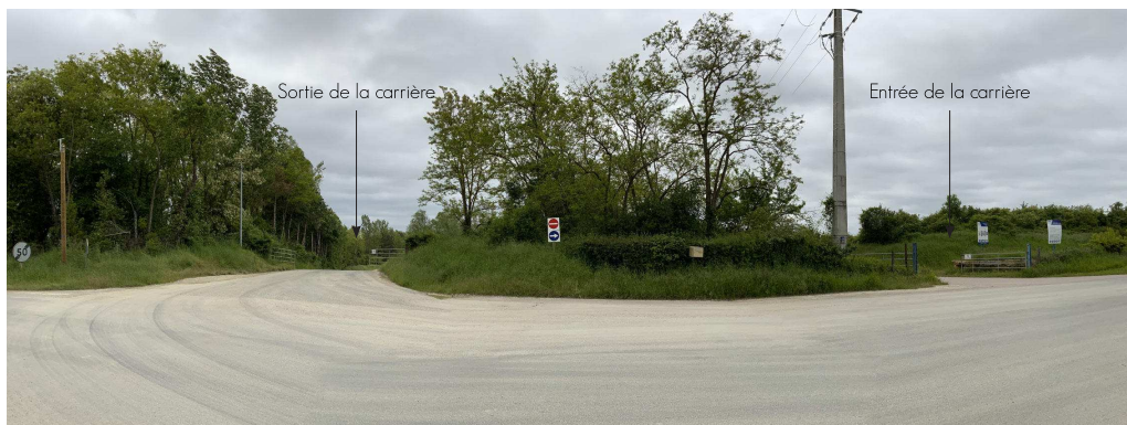
Vue 2a - Vue depuis le Nord du site sur le talus
