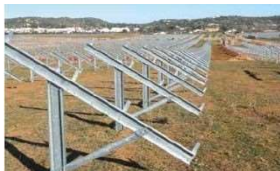
Figure 96 : Châssis fixe avec fondation de type pieux battus
