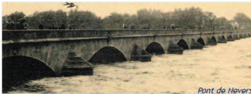
Fig. 5. : Crue du 19 octobre 1907 au Pont de Nevers
