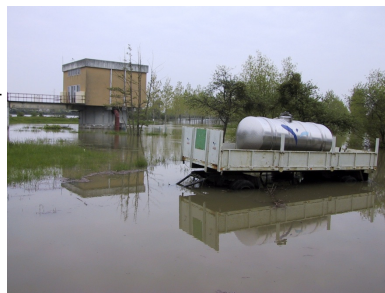
Crue décembre 2003 - Station eau potable Nevers
