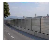
Digues avec ancrage
