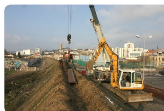
Levée de Saint-Eloi – travaux 2004
