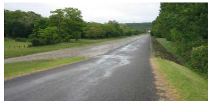
Déversoir du Guéhin
