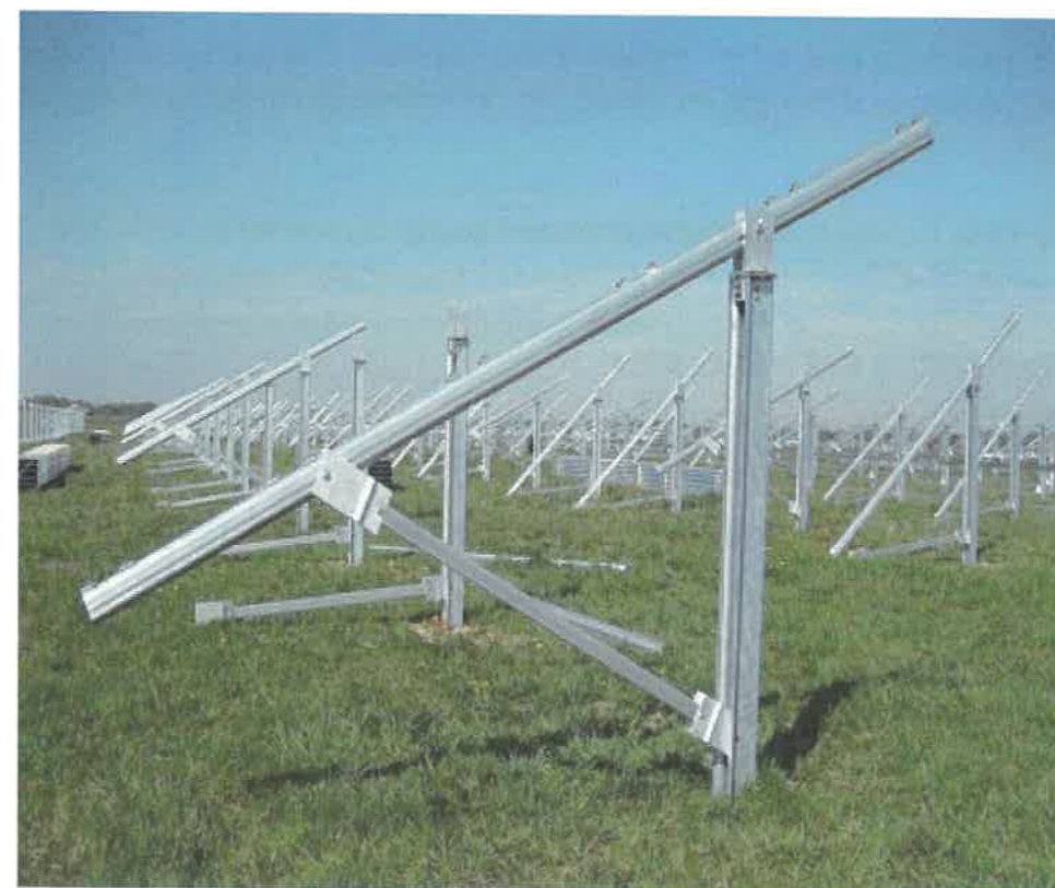
Exemple de structures et fondations envisagées
