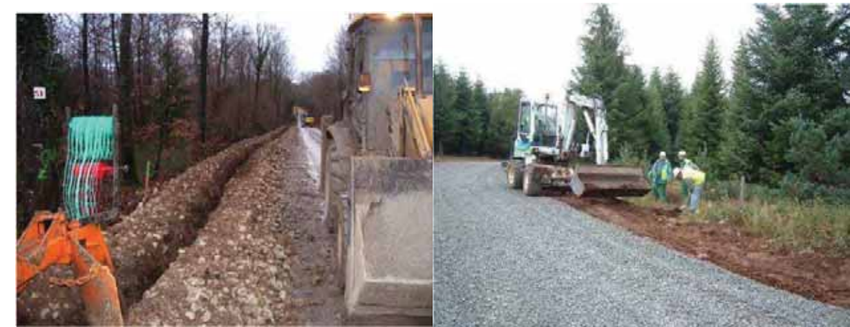
Photo 144 – Ouverture et fermeture de tranchée pour le raccordement électrique (Source : RES – Parc éolien de Forterre)
