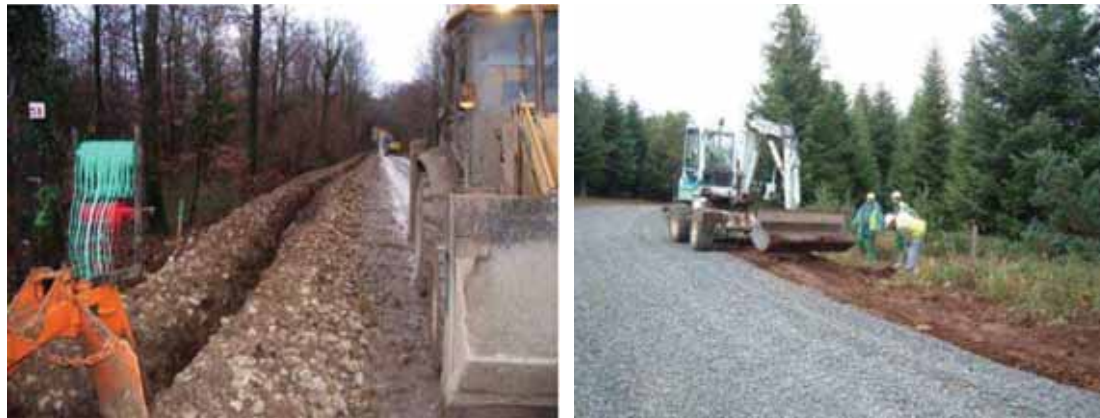
Photo 146 : Creusement et fermeture de tranchée pour le raccordement électrique vers le poste source (Source : RES)
