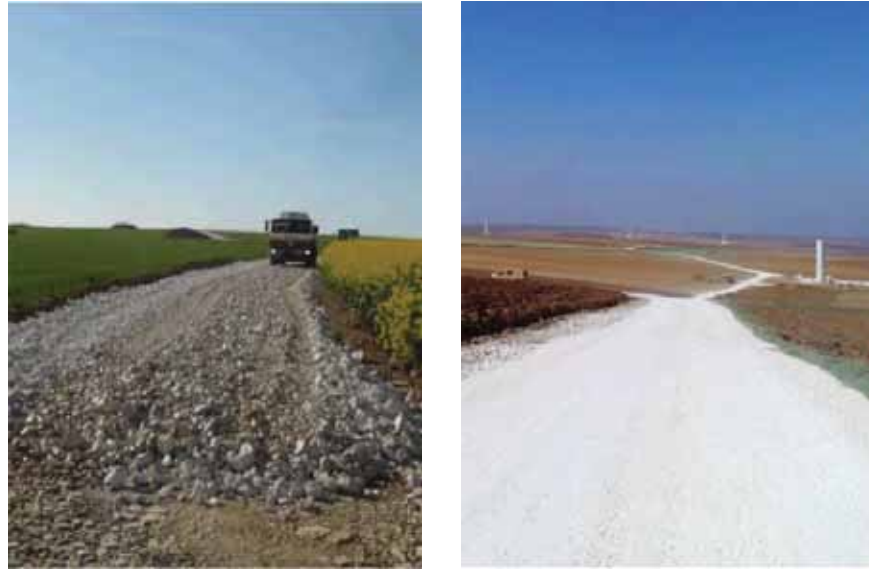
Photo 145 – Empierrement des voies avec des matériaux naturels : couche de fond (à gauche) et couche de finition (à droite) (Source : RES – Parc éolien de Forterre)
