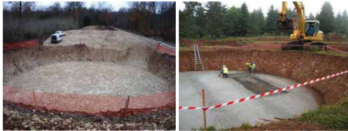
Photo 142 : Excavation et pose de béton armé (Source : RES)
