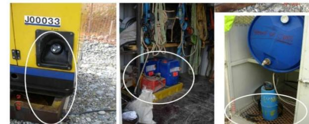
En parallèle, des kits antipollution (nombre disponible proportionnel au nombre d'engins sur site), barrage antipollution ou produits absorbants sont mis à disposition sur le chantier à proximité des engins de chantier.
