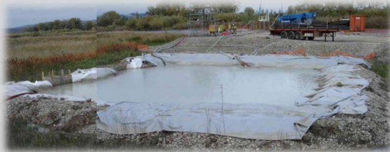
Figure 12 : Bassin provisoire de décantation des MES et autres polluants
