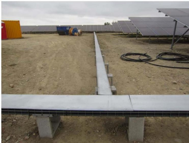
Figure 13 : Exemple de réseau de câbles hors-sol (source : NEOEN)
