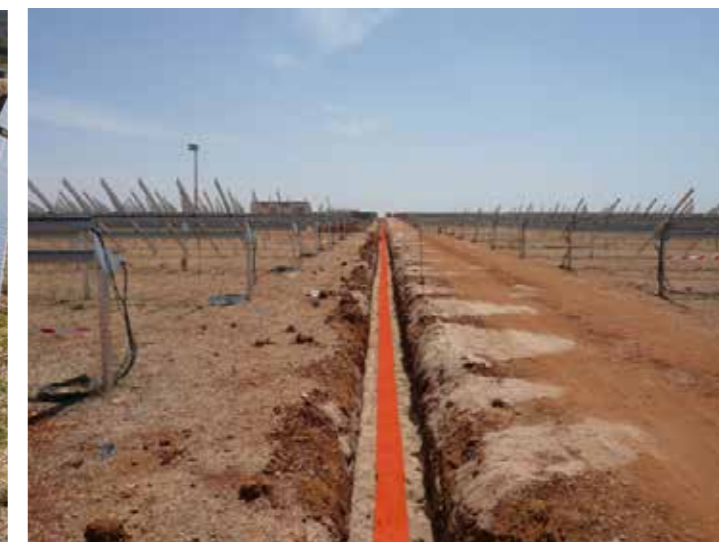
Pose des structures porteuses et raccordement interne
