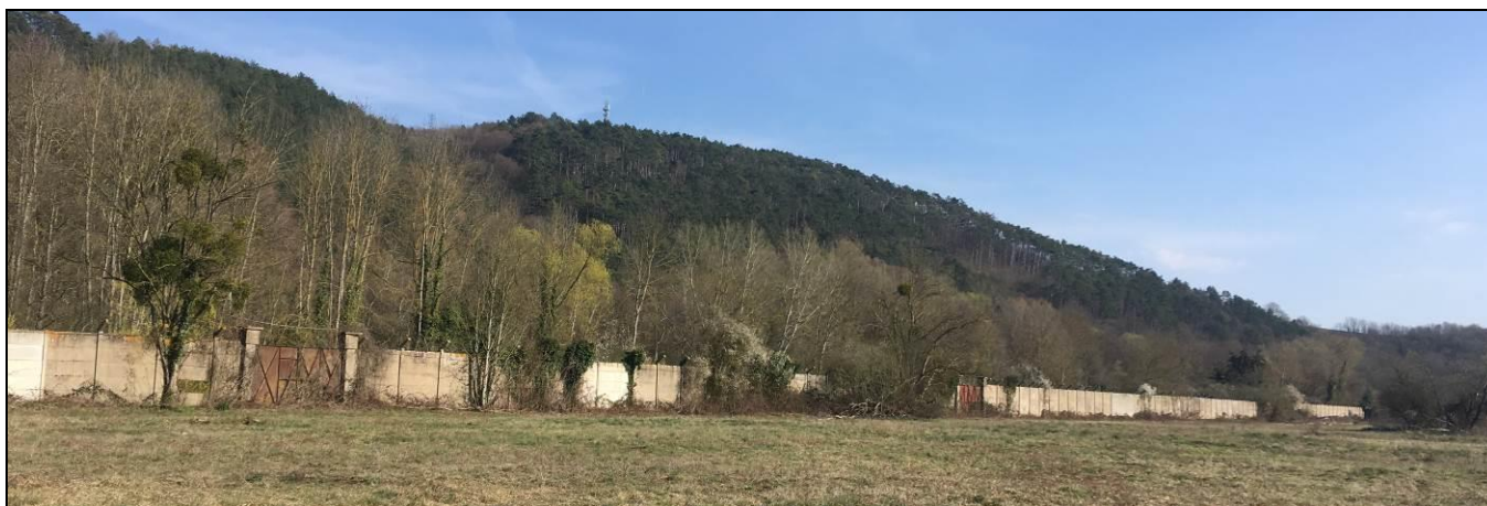
Figure 93 : Cliché du mur d'enceinte actuel
