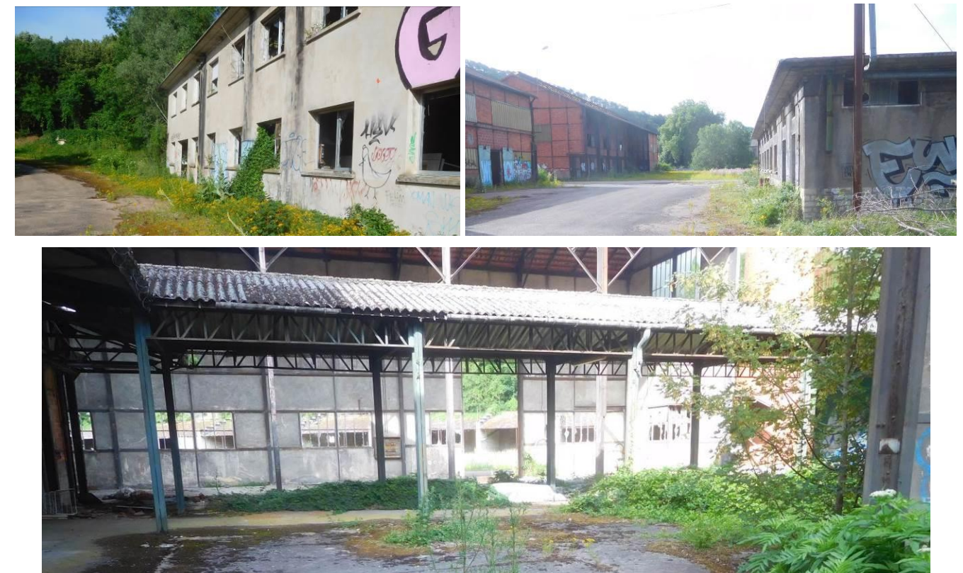
Photo 23 : Des bâtiments insalubres régulièrement investis par des personnes s'introduisant illégalement sur le site
