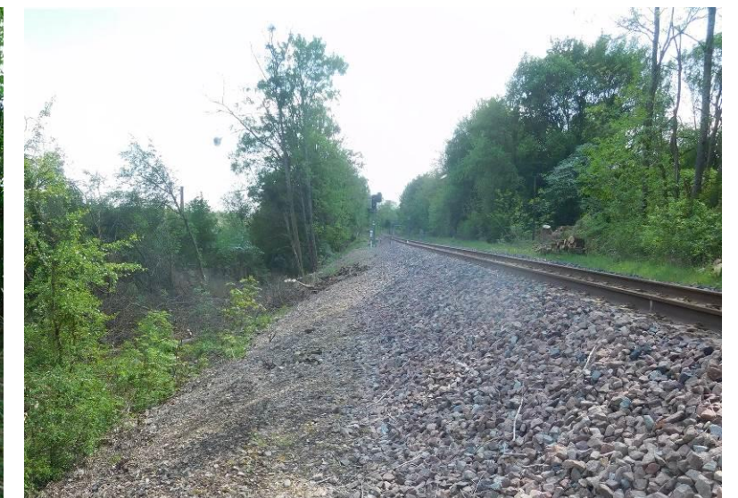
7- La voie ferrée, entretenue.
