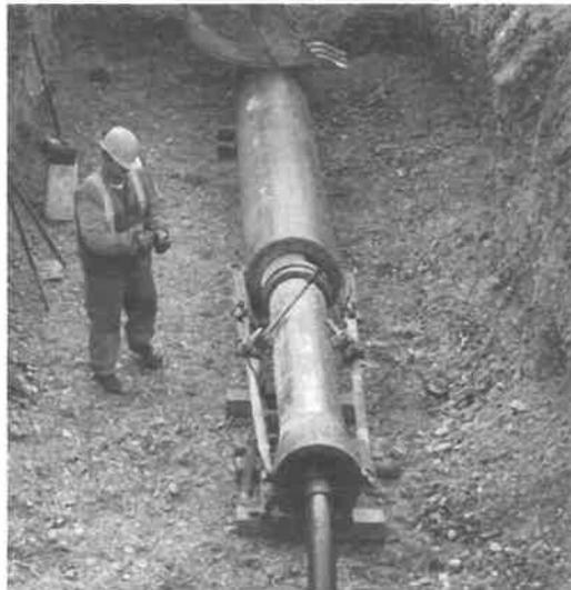
Figure 13 : Marteau pneumatique
