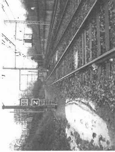
Figure 33 : TSV Paray Vieille Poste – Soulèvement des voies
