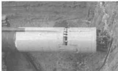
Figure 4 : Vue de profil d'une trousse coupante hydraulique orientable
