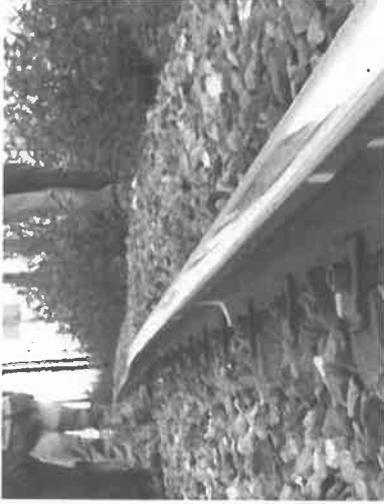
Figure 30 : TSY Noisy le sec – Soutèvement de 86.1 mm
