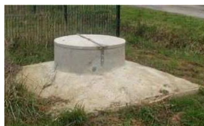
dalle ciment et capot étanche
