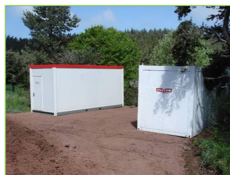
Vestiaires et bureaux de chantier
