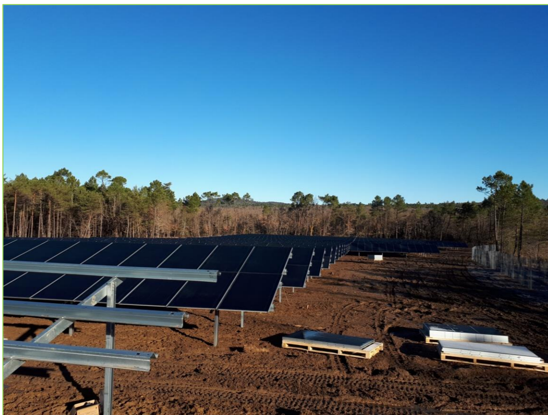
Figure 36 – Exemple d'installation de modules sur les structures porteuses (source : ADEN)
