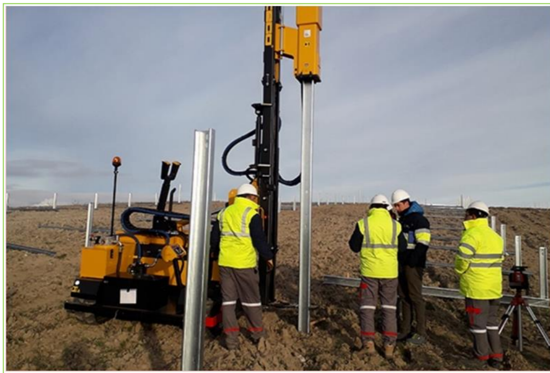
Figure 37 – Exemple d'implantation de pieux battus (source : ADEN)
