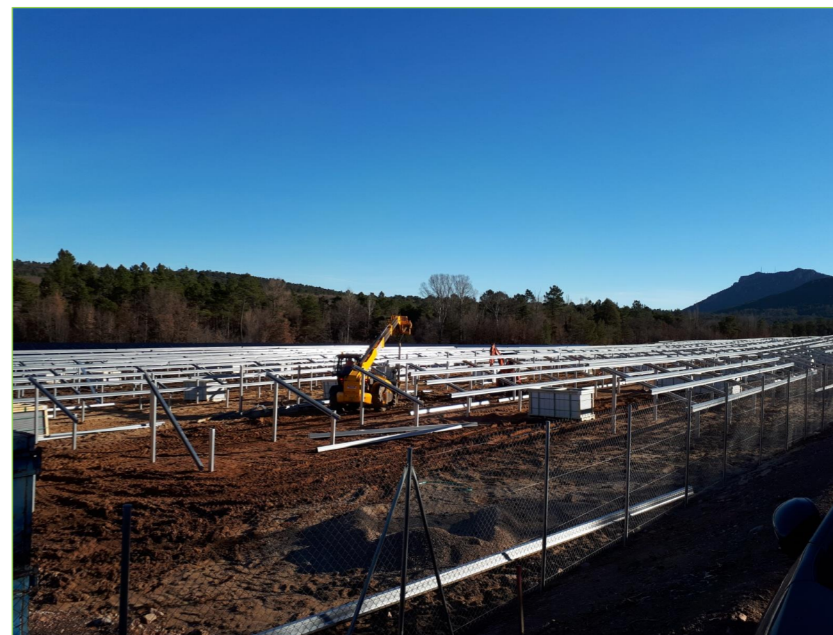
Figure 35 – Exemple d'installation de structures porteuses (source : ADEN)
