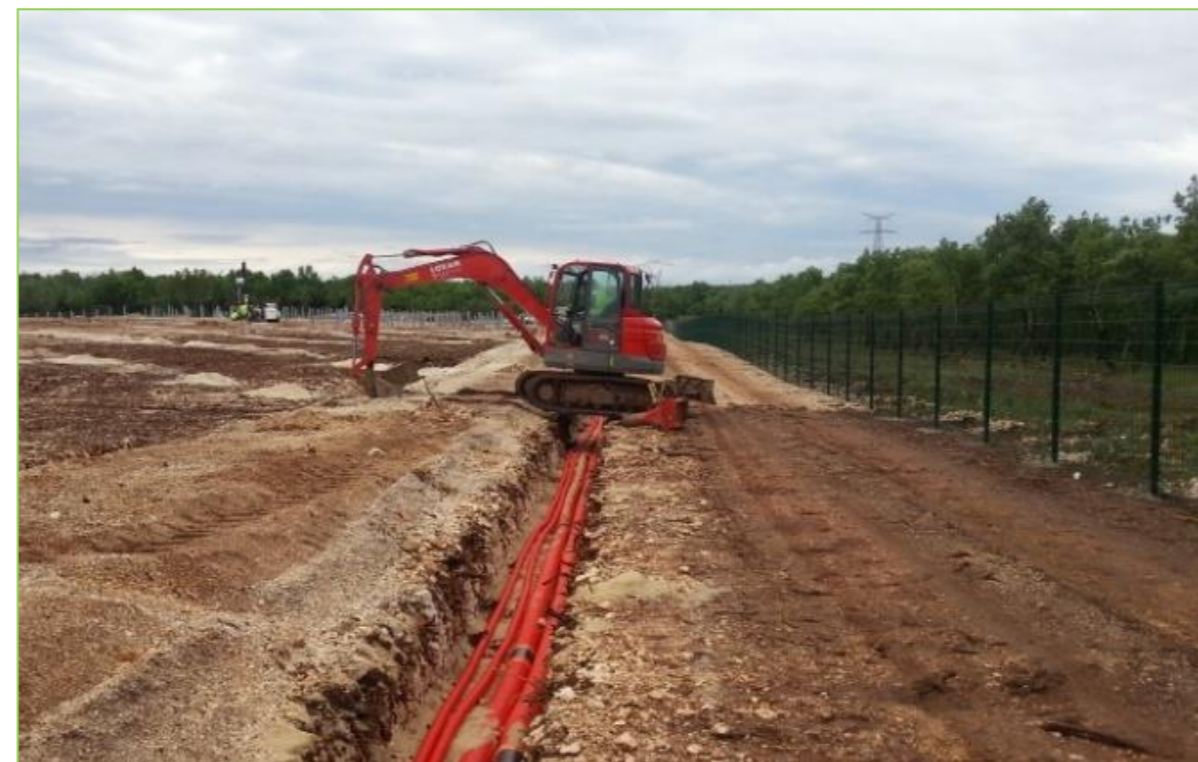
Figure 34 – Exemple de réalisation de tranchées électriques (source : ECO-STRATEGIE)
