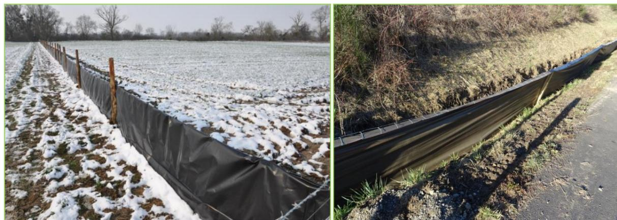
Photographie 70 - Exemple de clôture imperméable à la petite faune (Source : ECO-STRATEGIE)
