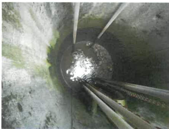
Photos 1 et 2 : Vue du poste de relevage en entrée, du canal de dessablage et du dégrilleur automatique
