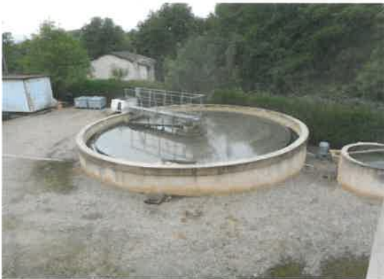
Photos 7 et 8 : Vue du clarificateur et du canal de comptage
