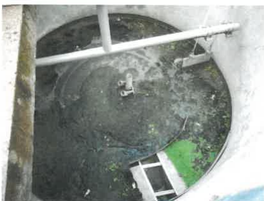
Photos 3 et 4 : Vue du dégraisseur et du bassin d'aération
