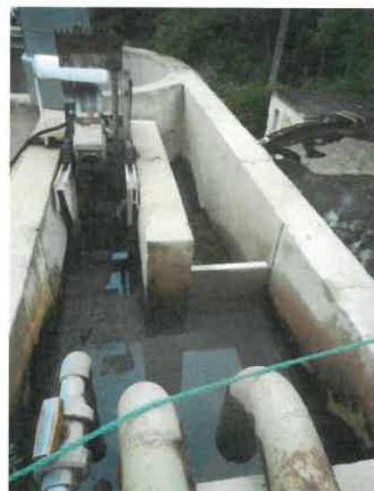
Photos 1 et 2 : Vue du poste de relevage en entrée, du canal de dessablage et du dégrilleur automatique
