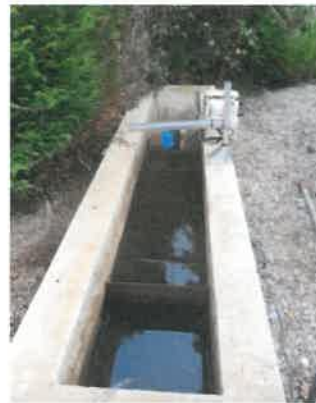
Photos 7 et 8 : Vue du clarificateur et du canal de comptage
