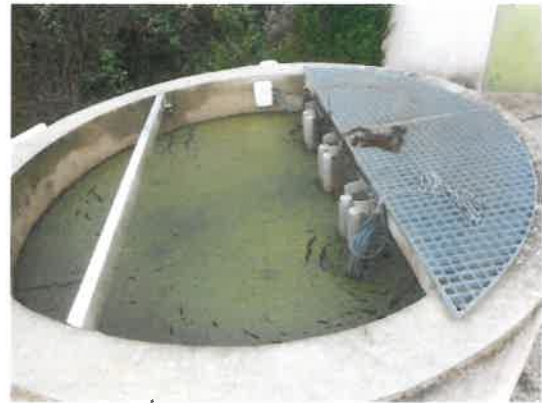
Photos 5 et 6 : Vue du puits de dégazage et du puits de recyclage des boues
