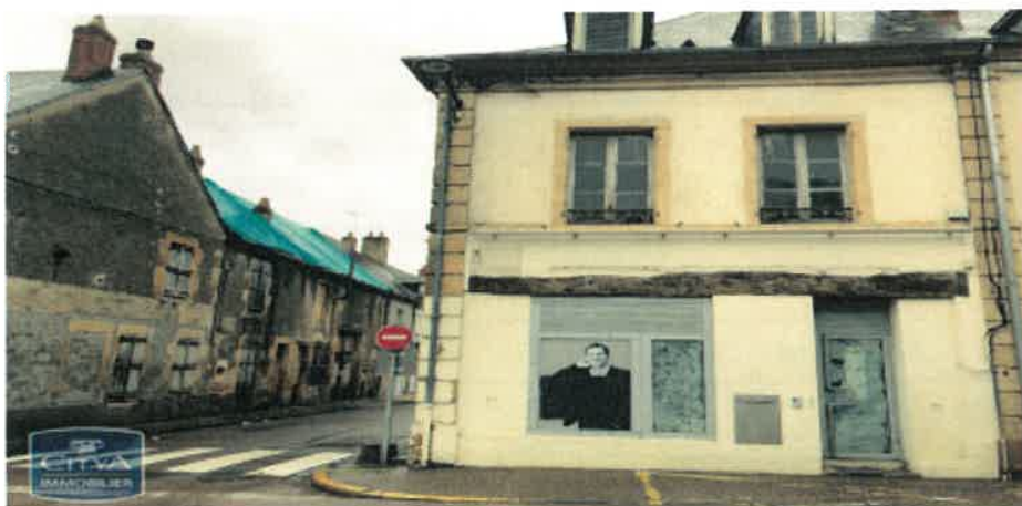
Illustration : locaux de l'ancienne Caisse d'Epargne, dans la Grande Rue
