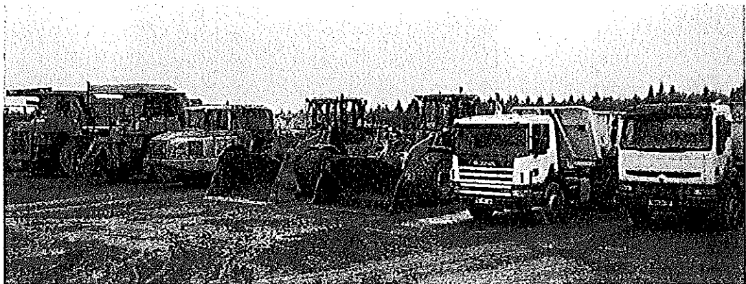
Engins stationnés sur l'aire bétonnée étanche
