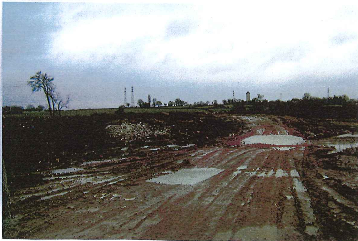
CLICHE N°2 : Remblais en cours, partiellement en zone « A ».
