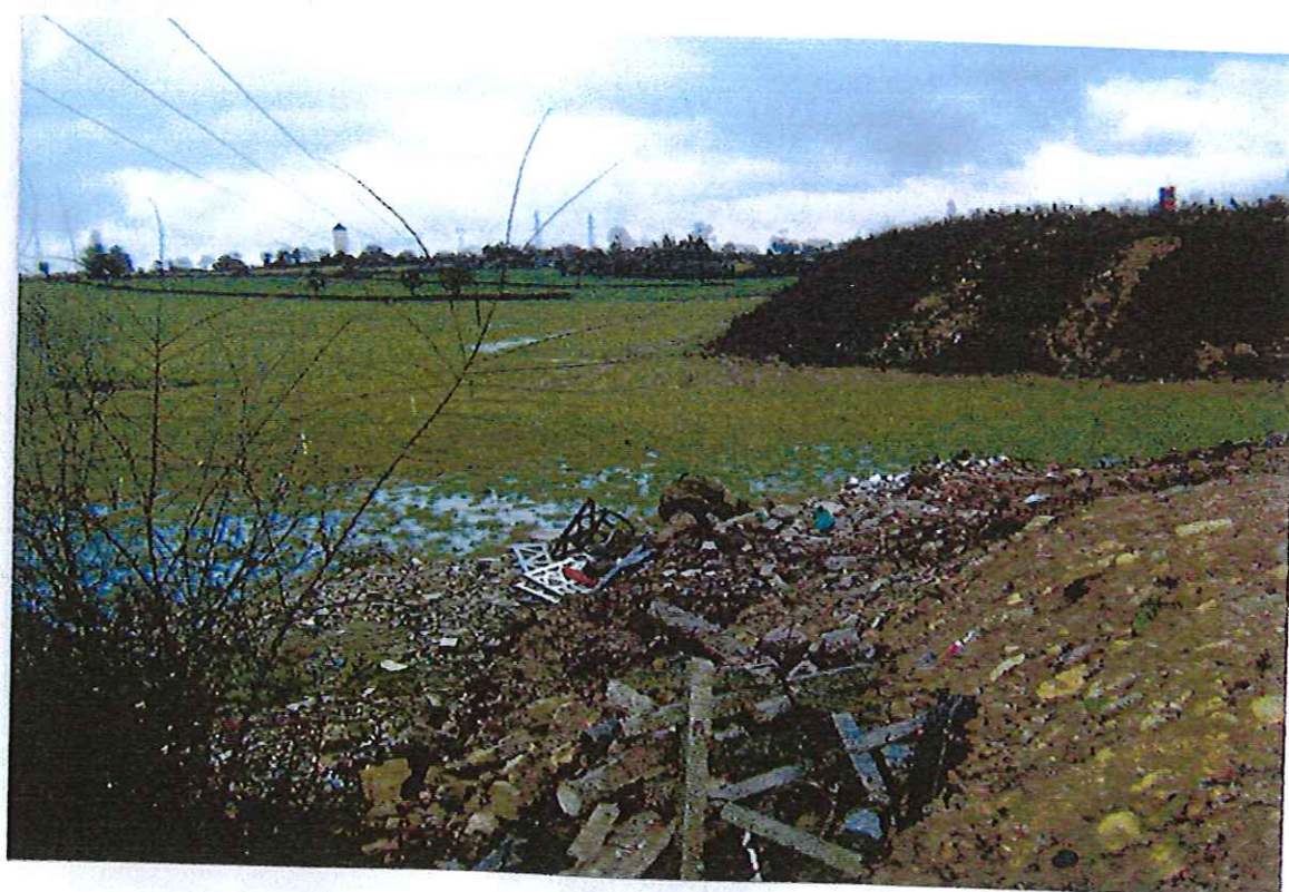
CLICHE N°4 : Remblais en cours, en zone « A », en limite de propriété de Monsieur HANNON
