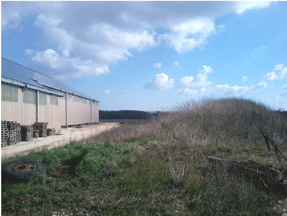
Ci-dessus : vue de la zone avant mise en place du projet
