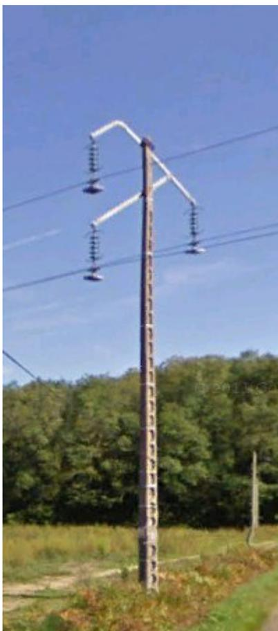
La ligne électrique aérienne à 63 000 volts est constituée d'un circuit électrique triphasé.
