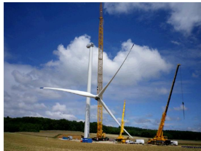
Assemblage des pales et levage du rotor : deux techniques sont envisageables : soit par levage du rotor complet (moyeu et pales assemblés au sol), soit par levage pale par pale. La technique pale par pale sera privilégiée.
