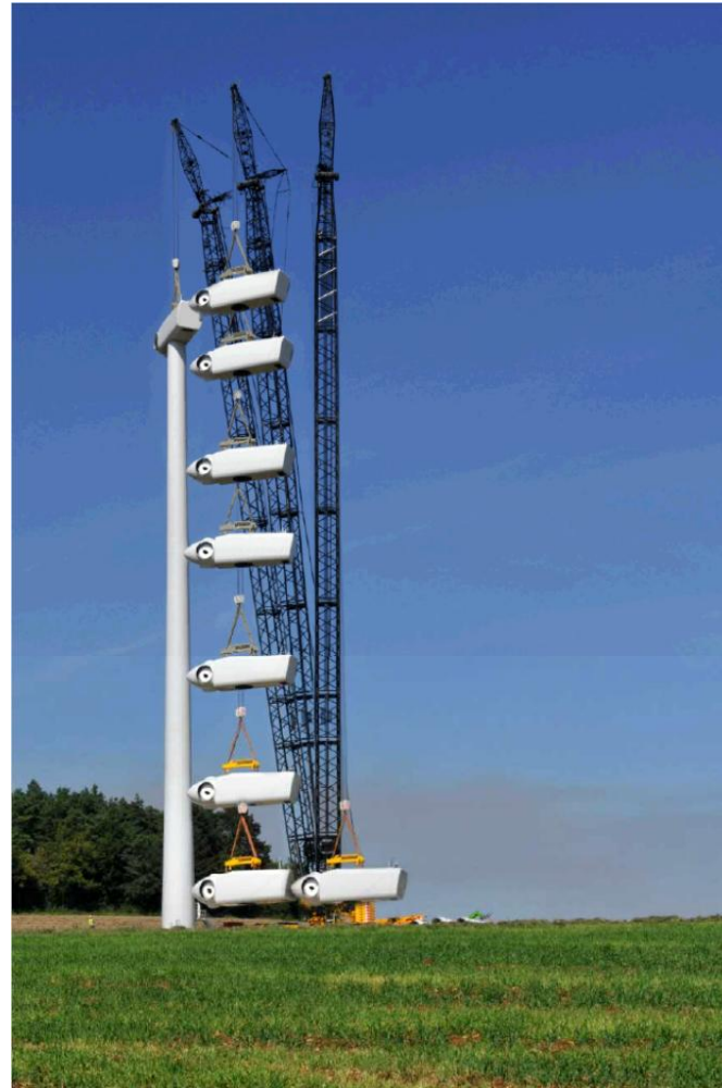
Levage et assemblage de la nacelle : une fois le mât entièrement assemblé, la nacelle de l’éolienne est levée et fixée au mât.
