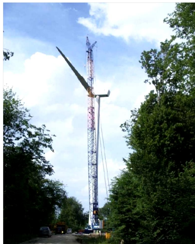
Assemblage des pales et levage du rotor : deux techniques sont envisageables : soit par levage du rotor complet (moyeu et pales assemblés au sol), soit par levage pale par pale. La technique pale par pale sera privilégiée.
