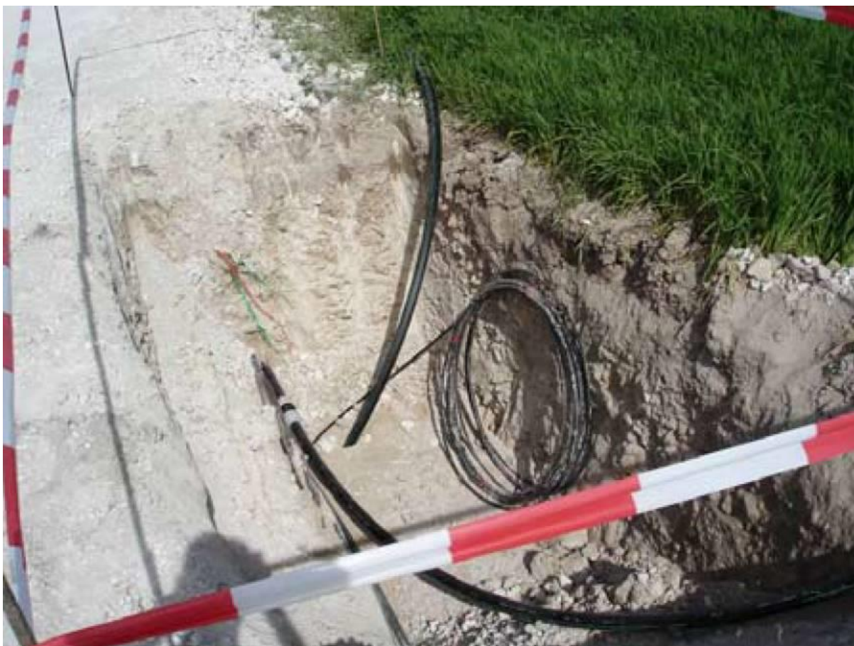
FIGURE 28 : PHOTO D'UNE TRANCHEE POUR L'ENFOUISSEMENT DES CABLES ELECTRIQUES
