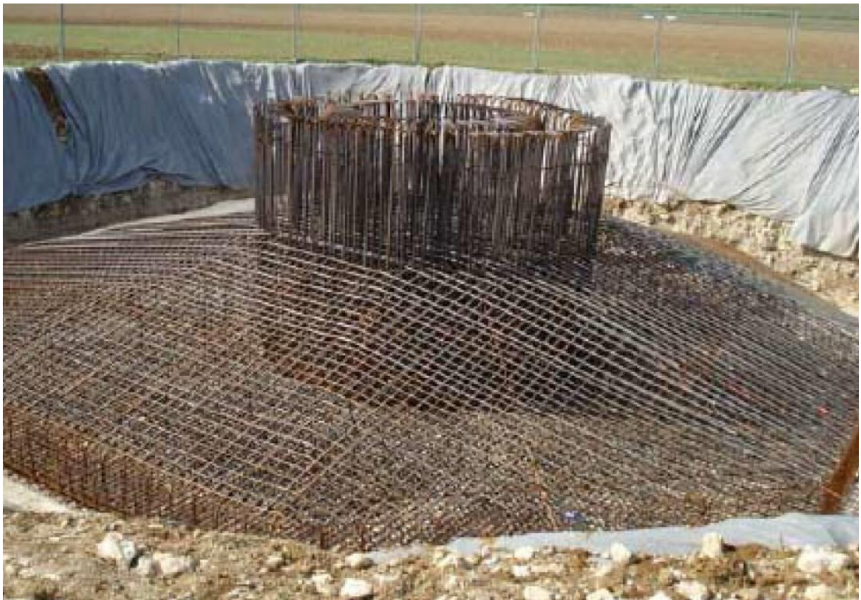
FIGURE 8 : PHOTO DU FERRAILLAGE D'UNE FONDATION TYPE
