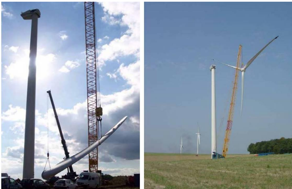
FIGURE 26 : GRUE DE MONTAGE ET ELEVAGE DU ROTOR
