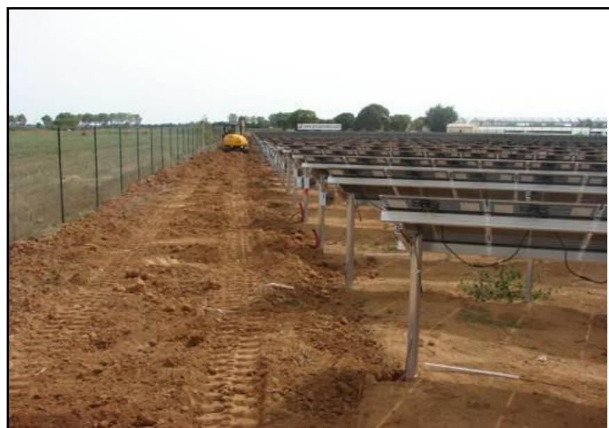
Illustration 108 : Récouvrement des tranchées
