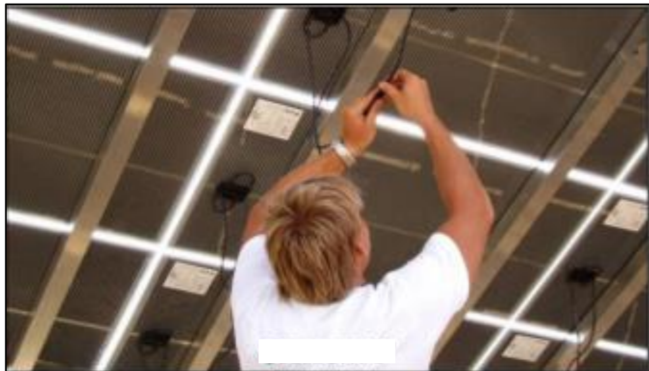
Illustration 98 : Vues des interstices de 2 cm entre chaque panneau
