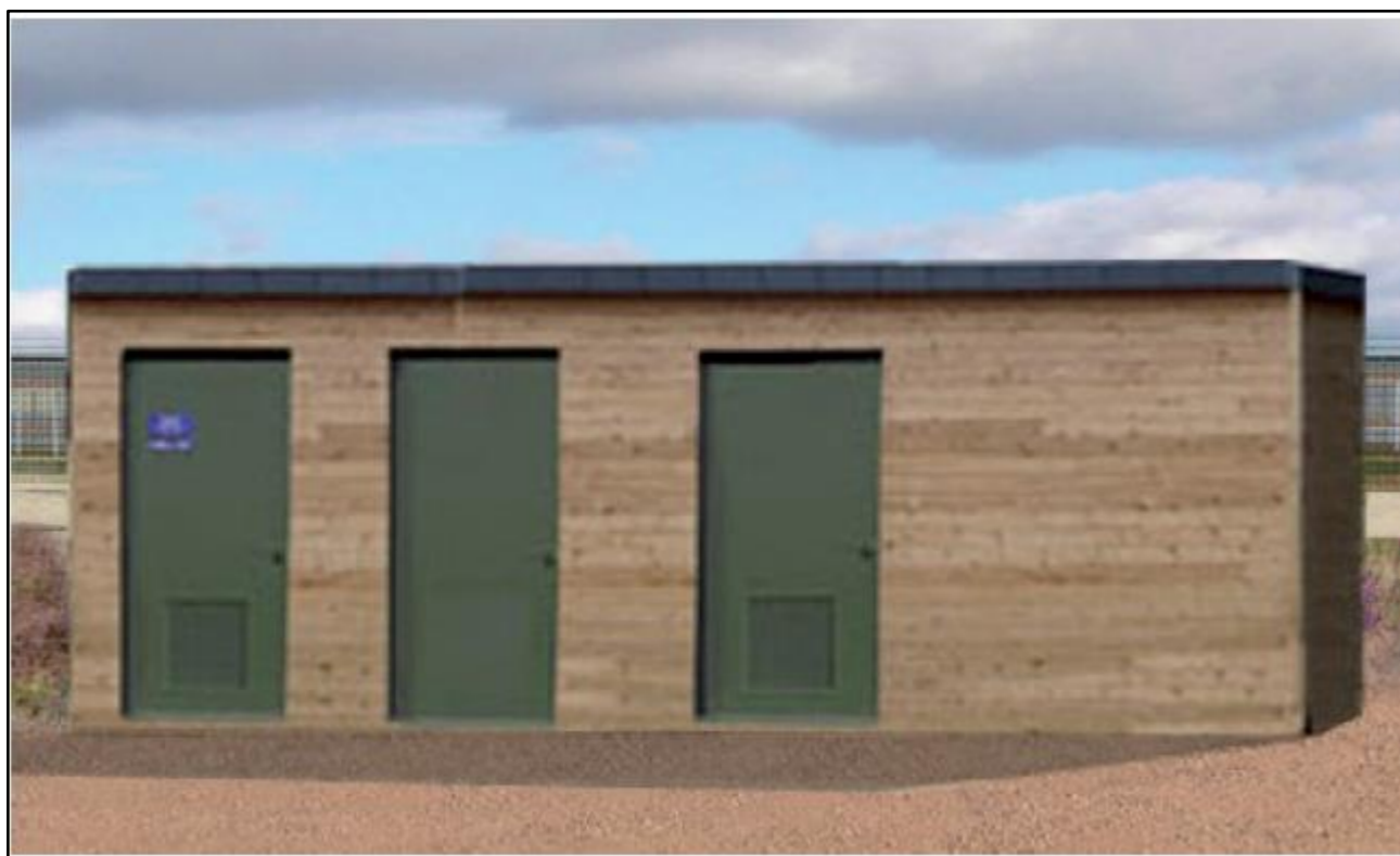
Illustration 41 : Exemple de poste de livraison avec bardage bois horizontal et traitement des menuiseries
