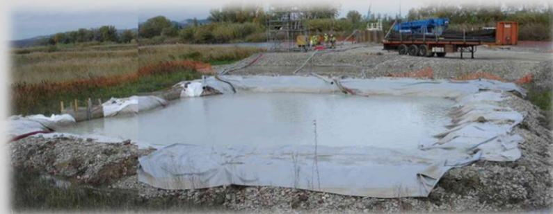
Figure 31 : Bassin provisoire de décantation des MES et autres polluants
