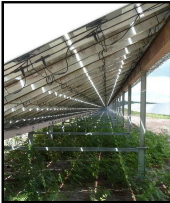
Photo 20 : Rais de lumière filtrant à travers les interstices de 2 cm disposés entre les modules
