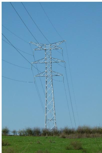
*Exemple de supports double circuit*
